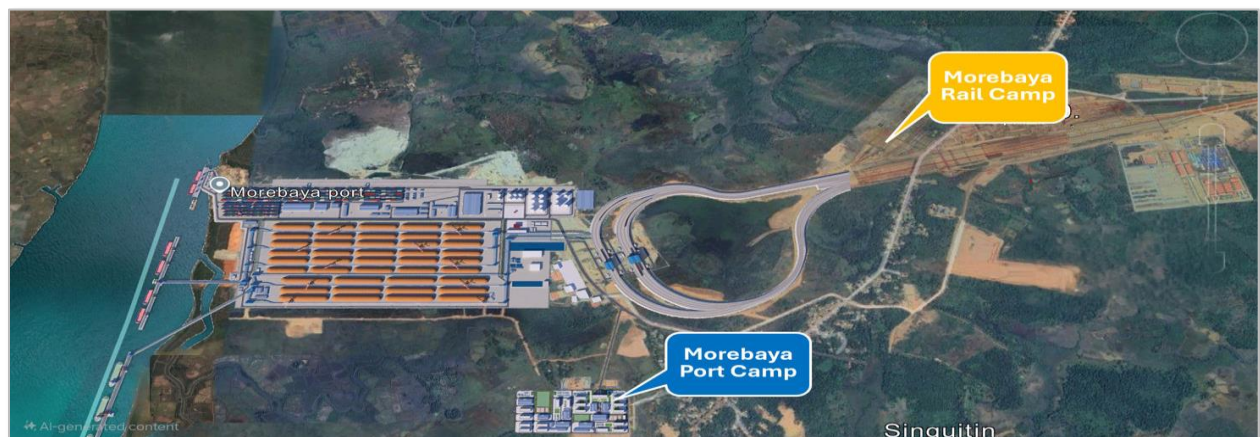
Figure 2 Emplacements des camps du port et du chemin de fer situés au port de Morebaya
